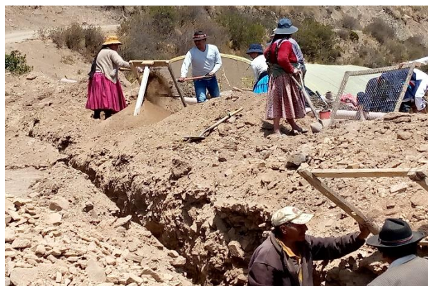
Fotografía: Construcción de alcantarillado, Jucumarca (García, 2022)
